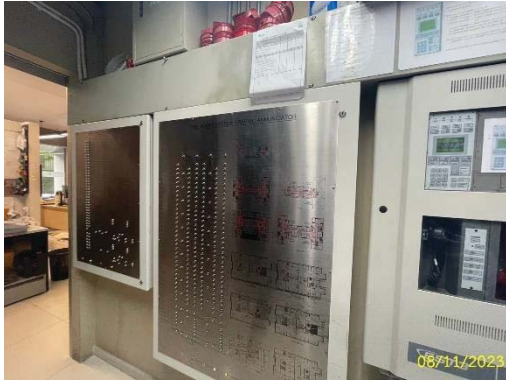
แผงควบคุม (Fire Alarm Control Panel)
